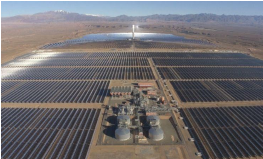
Abb.7: Noor in Ouarzazate, Solarkraftwerk in Marokko (Ziel 2000 MW bis 2020; Strom für 1 Millionen Menschen, 3 CSP (Solarthermie) und eine PV Anlage)
